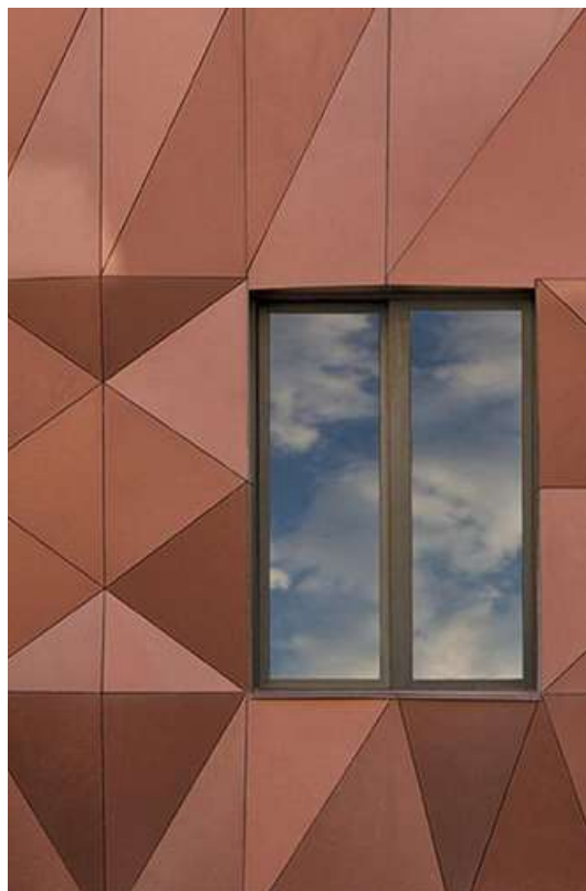
Fachada con HPL de Trespa.
