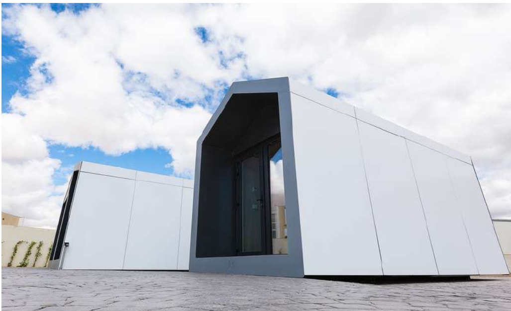
Fachada Minimal Oficinas Asai, en panel composite de aluminio.
