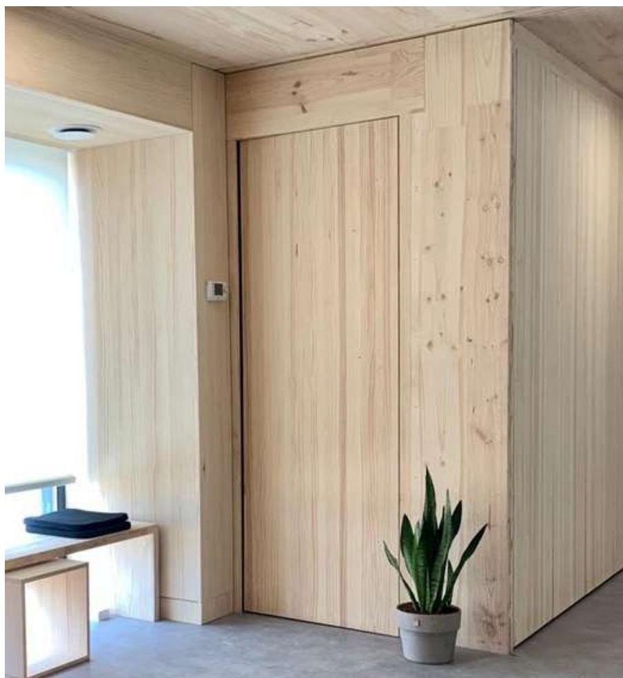
Puertas enrasadas, Oficinas Minimal Montepino, Lisboa.
